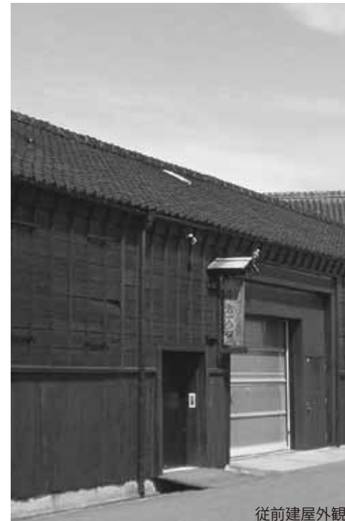
従前の「酢の里」エントランス棟
