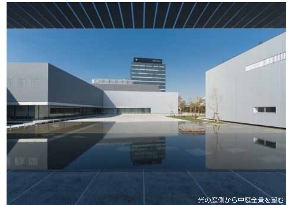
南側街路から建物越しに中庭を望む
