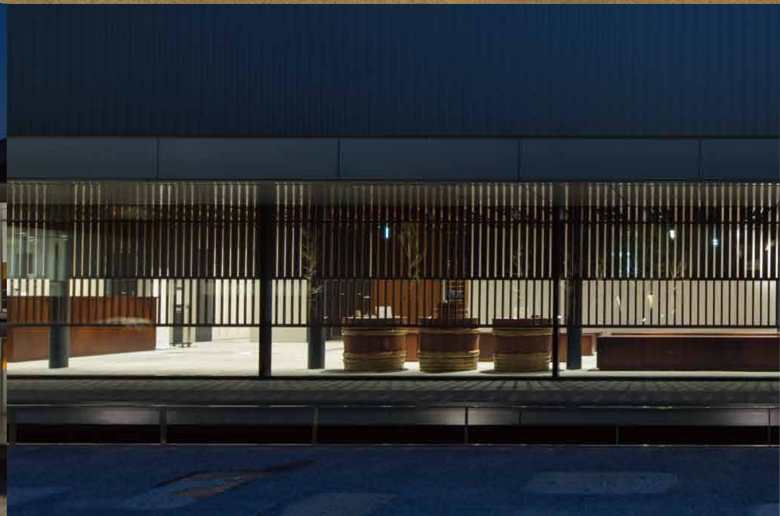
中庭からエントランスを見る 手前に埋め込められた大判の石も古材を再利用したもの
