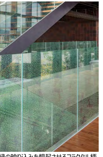
緑の映り込みを想起させるフラクタル柄グラフィックプリントが施されたガラス手摺
